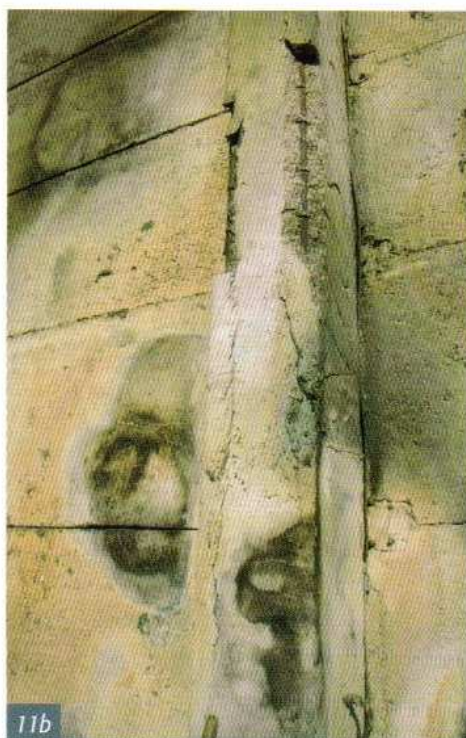
Obr. 6 Vznik trhlin od nerovnoměrného oteplení Fig. 6 Cracks development due to non-uniform temperature distribution
