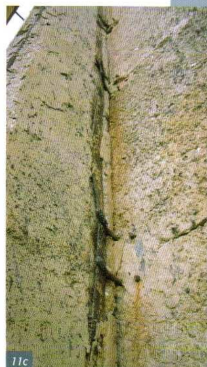
Obr. 6 Vznik trhlin od nerovnoměrného oteplení Fig. 6 Cracks development due to non-uniform temperature distribution
